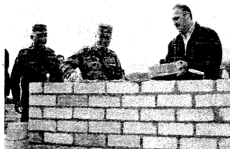
LA ACTIVIDAD más importante en la que se puede invertir recursos de los mexicanos, es brindar certeza y seguridad, afirmó ayer José Calzada Rovirosa al colocar la primera piedra de la base militar de Arroyo Seco.
