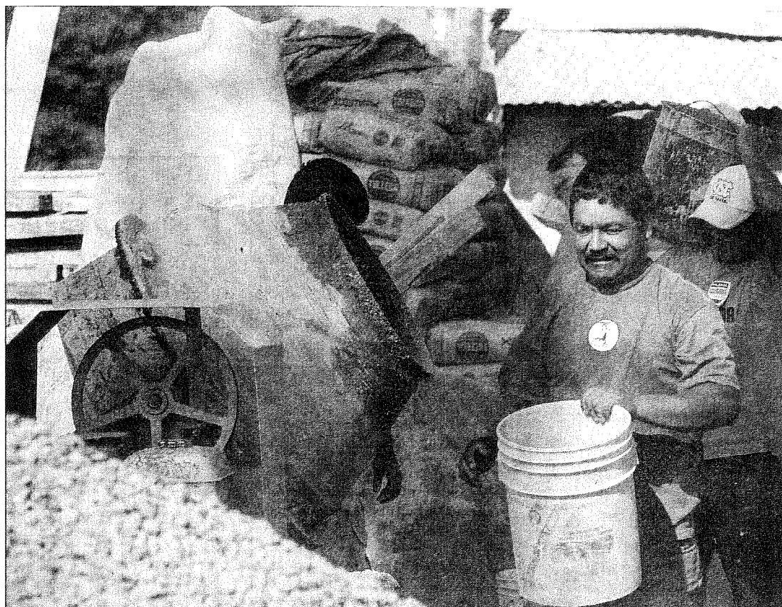
Los recursos que necesita el Municipio de Querétaro para realizar las obras son más de 350 millones de pesos
