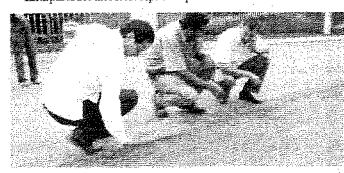
INTENSA GIRA de supervisión de trabajos en diversas vialidades realizó ayer el alcalde Francisco Domínguez Servién en compañía del titular de Obras Públicas Municipales Santiago Martínez.
