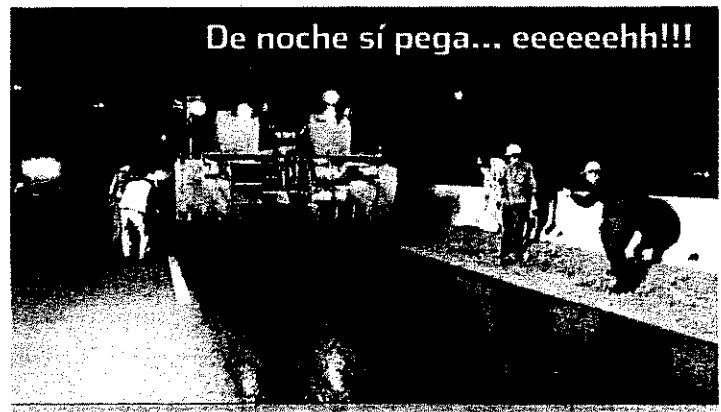
La Comisión Estatal de Caminos dio inicio formal a los trabajos de doble riego de sello en la Carretera Estatal 57 y Avenida 5 de Febrero, como parte de la tercera etapa de mantenimiento y prevención que se realiza en esta vialidad
