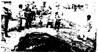
Este boquete se abrió durante la madrugada de ayer en 5 de Febrero; inicio con unos 30 centímetros de diámetro; por la tarde terminó con más de un metro de diámetro y tres de profundidad. Foto Patricia Juárez
