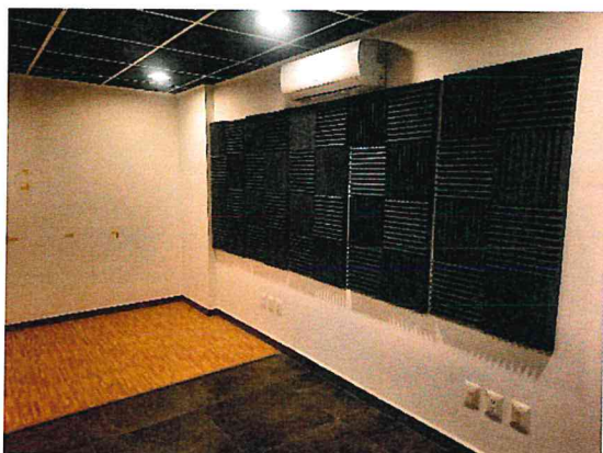
Instalación de mini-splits.
