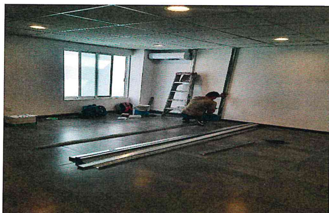
Inicio de tratamiento acústico
