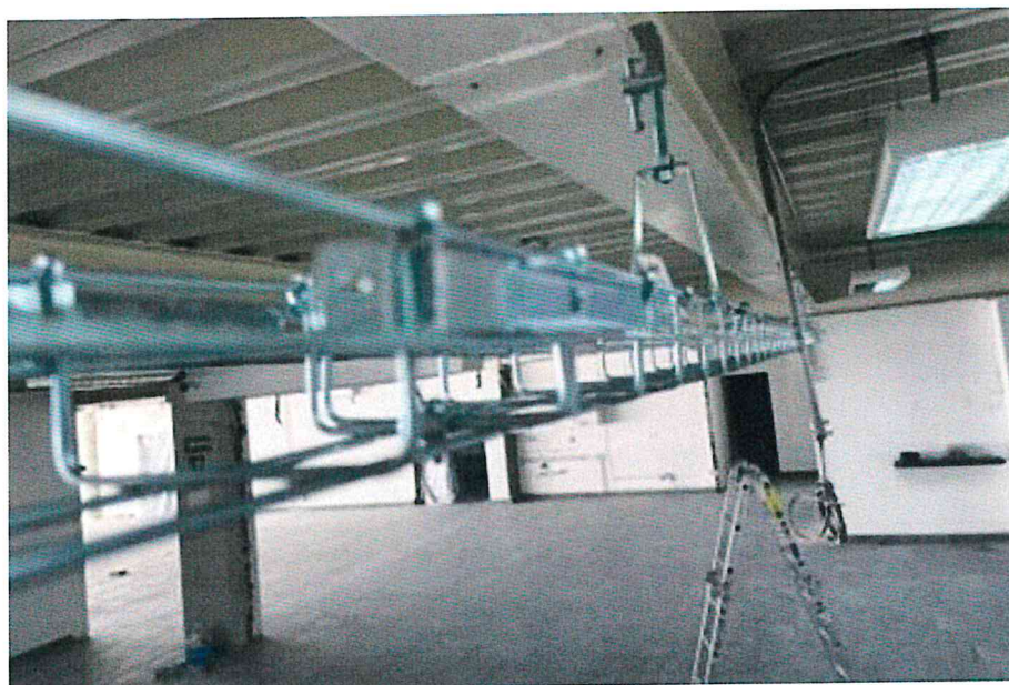
Instalación de rejilla metálica para cableado de red de voz y datos
